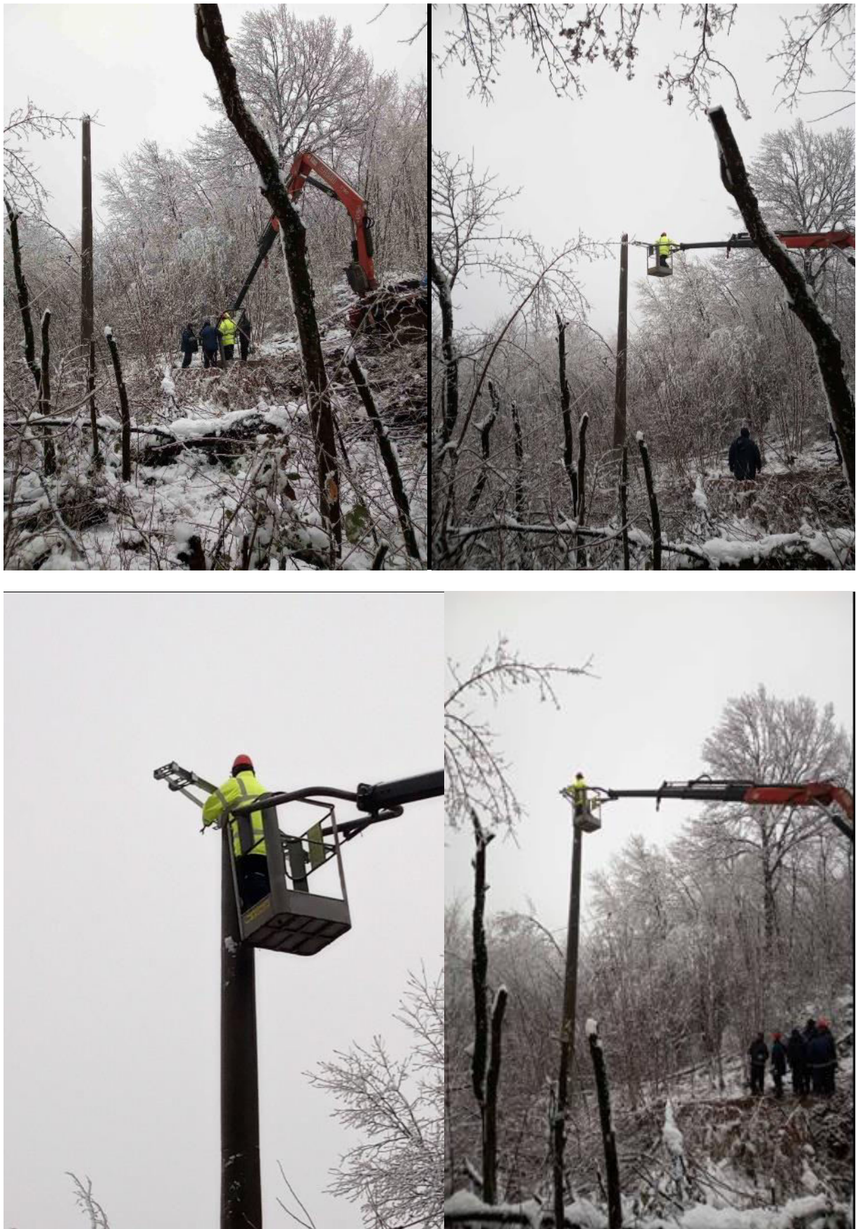
Slika 4. Montaža vršne konzole i potpornih izolatora PSI 36
