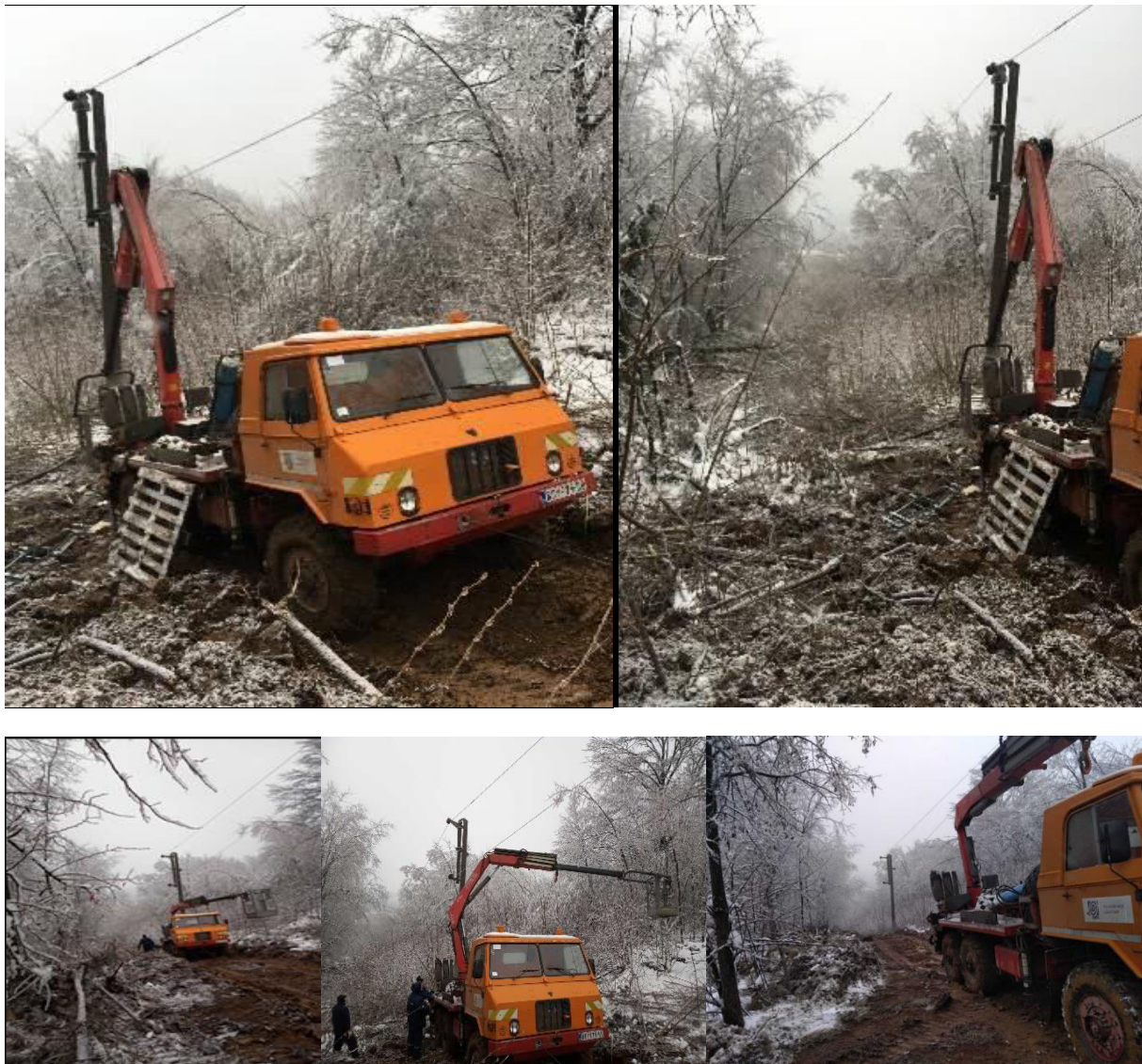
Slika 3. Sečanje dela stuba iznad mesta preloma I priprema za montažu vršne konzole
