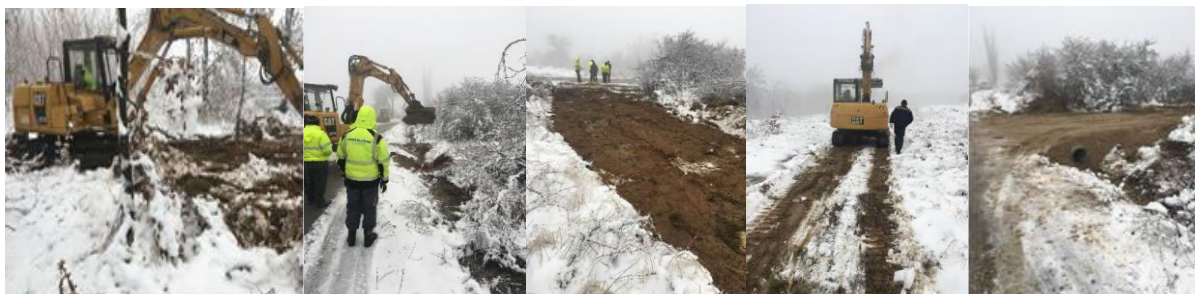
Slika 2. Detalji izgradnje pristupnog puta do mesta rada na dalekovodu 35 kV TS 35/10 kV/kV „Gadžin Han“ – TS 35/10 kV/kV „Dušnik“
